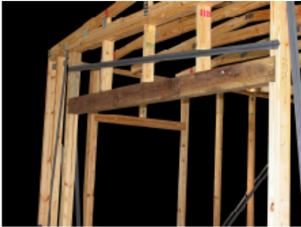
Solid 4x6" Double Door Header
